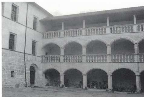
Fig. 3. — La galerie est du château de Clermont.
