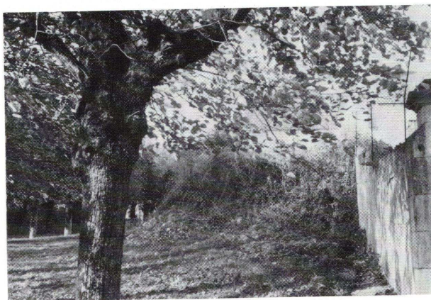
Fig. 1. — La base de la dernière des onze tours des remparts, sur le boulevard Livras.
