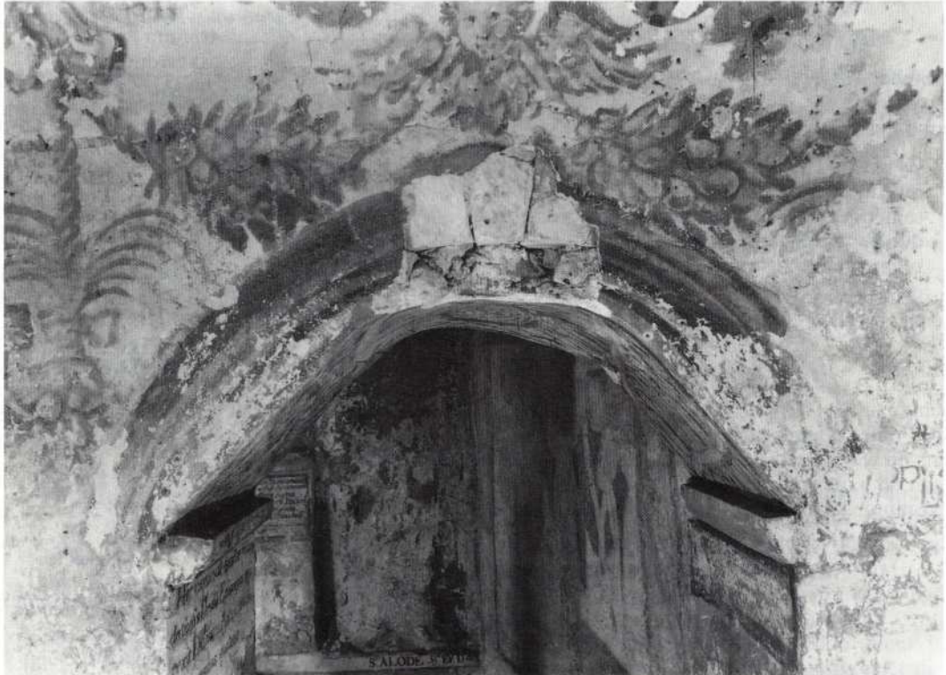
Fig. 15. — Le cubicule sud, vu de l'est.
